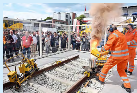
Thermitschweißen – Vorführung auf dem Außengelände.
