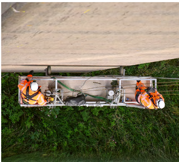
Foto: Autobahn GmbH/Susanne Schlenga
