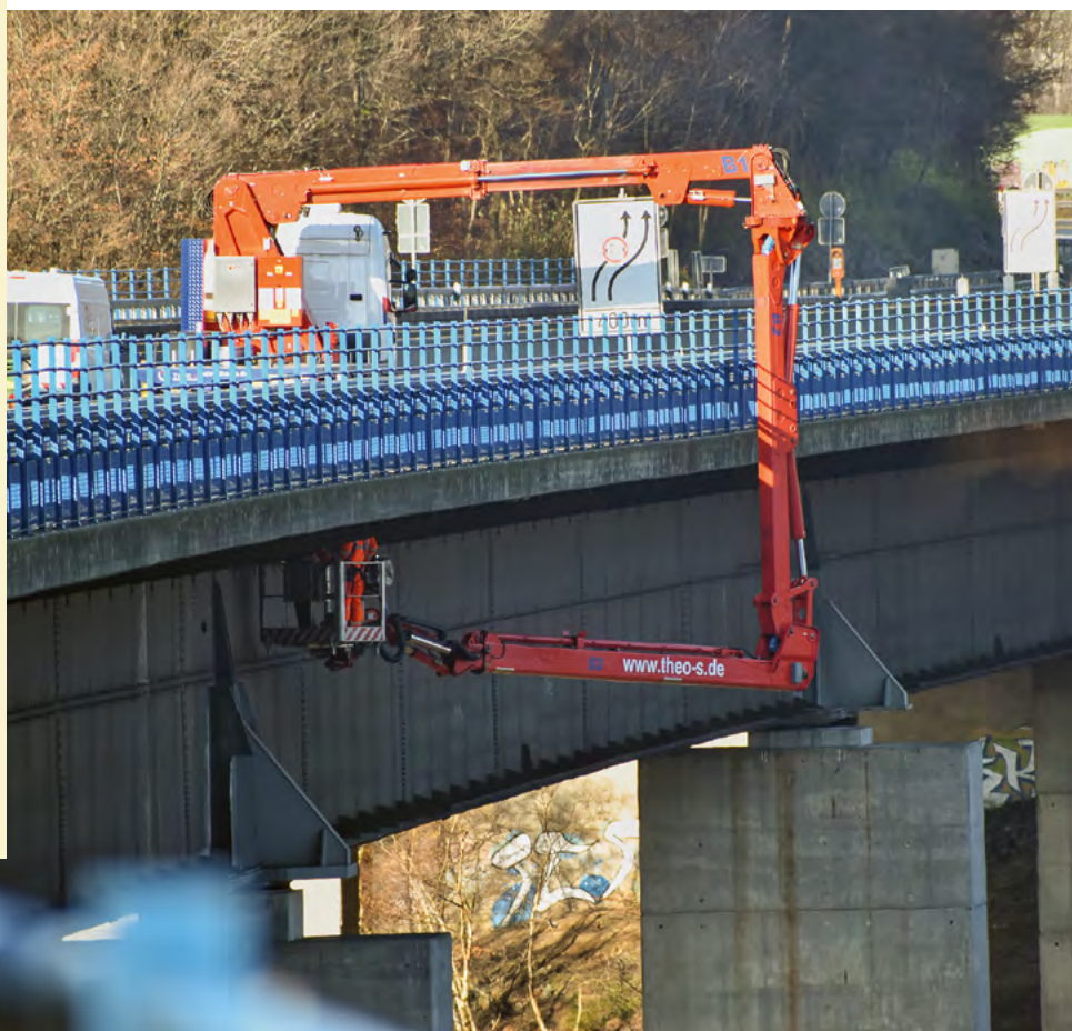
Foto: Autobahn GmbH/Susanne Schlenga
