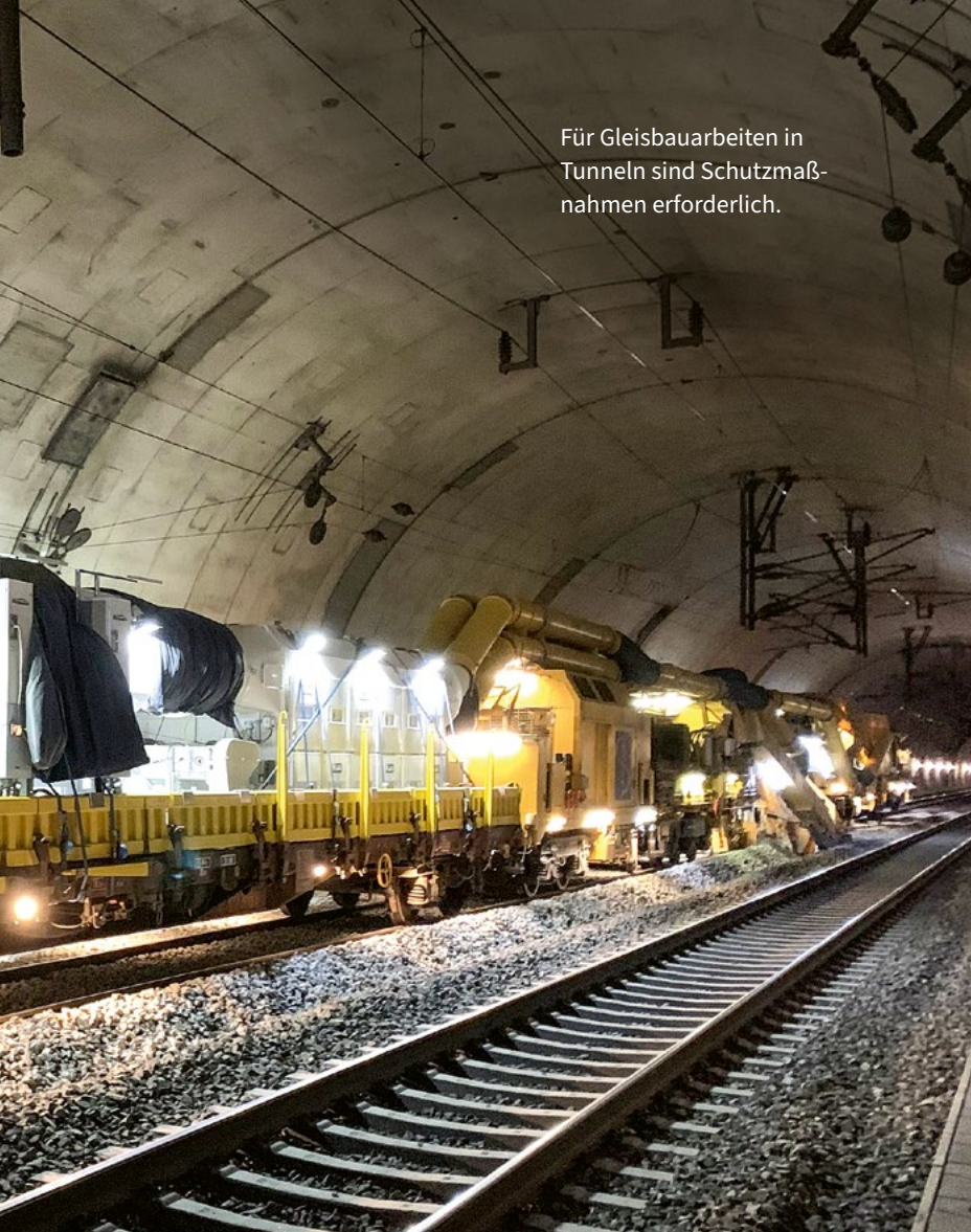
Foto: BG BAU
